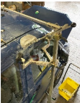
Richtvorgang am Dach
